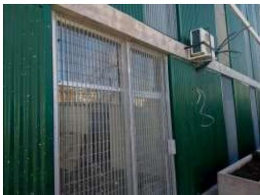
**Figura 1.** Detalle de perforaciones en los paneles por la colocación de equipos de aire acondicionado. Se observa el estado de los paneles exteriores con salpicaduras de material.
